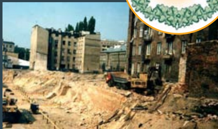
Wykop pod nasz pierwszy budynek, przy ul. Żelaznej.
