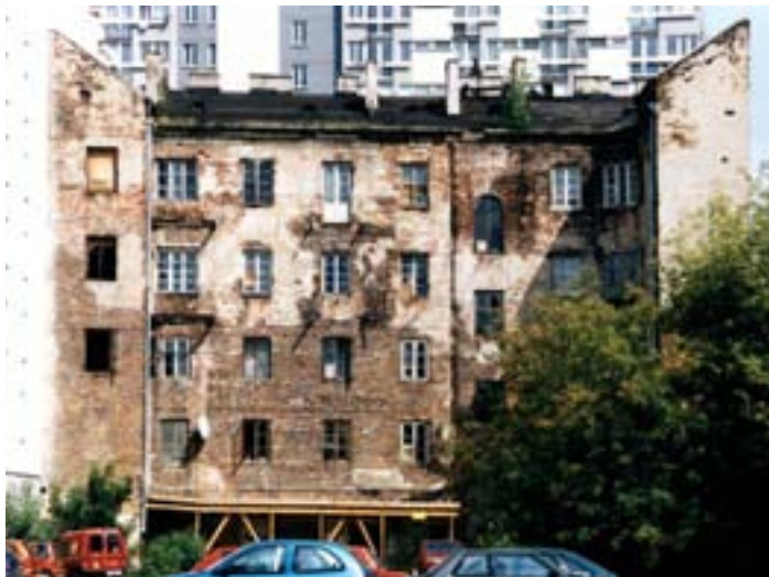
Widok kamienicy przy ulicy Żelaznej 65 od strony podwórka w roku 2000...
