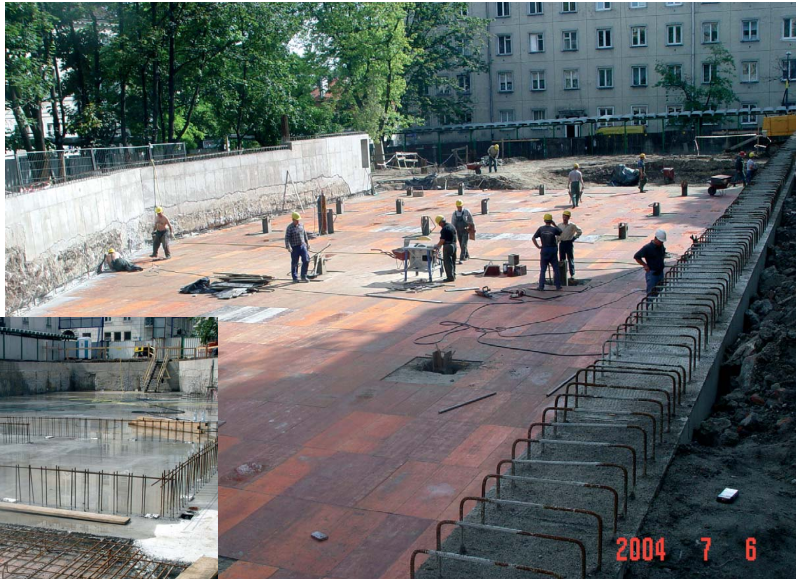
Ściany szczelinowe i strop rozpiętą na poziomie -1.
