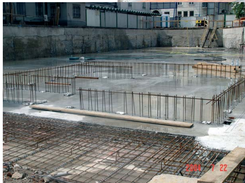
Ściany szczelinowe i strop rozpiętą na poziomie -1.
