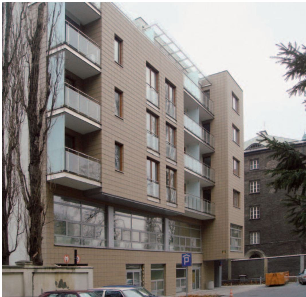
Elewacja Czrniakowskiej 131 dobrze wkomponowała się w otaczające budynki.
