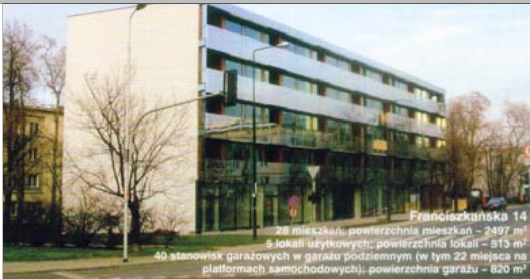
Pusta ściana nadal szpeci piękny budynek (zdjęcie sprzed roku)
